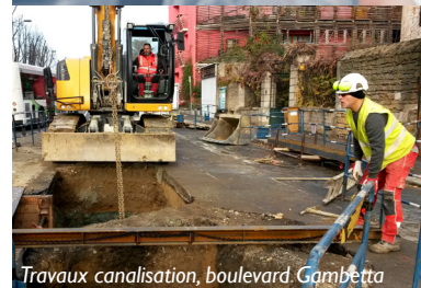
Travaux canalisation, boulevard Gambetta
